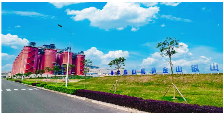
图 19：广西华昇分解槽
